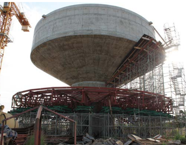
Château d'eau en construction aux alentours de Ouagadougou. Crédit photo ONEA
