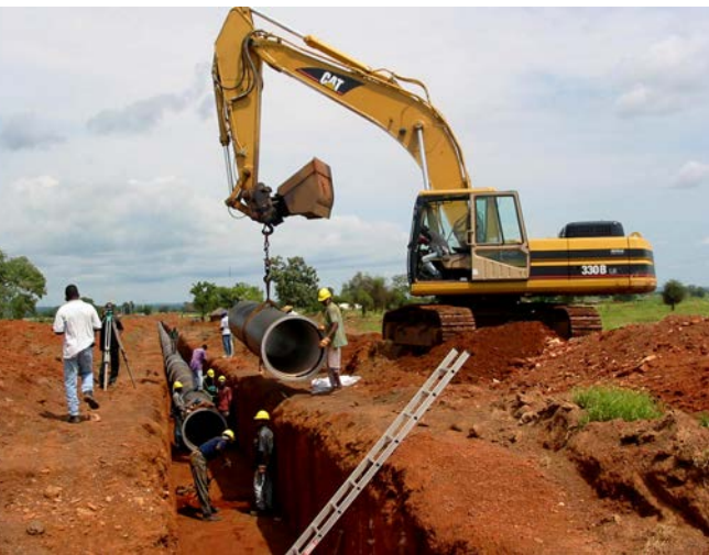
L'ONEA pose des conduites pour amener l'eau dans des quartiers éloignés de Ouagadougou. Crédit photo ONEA
