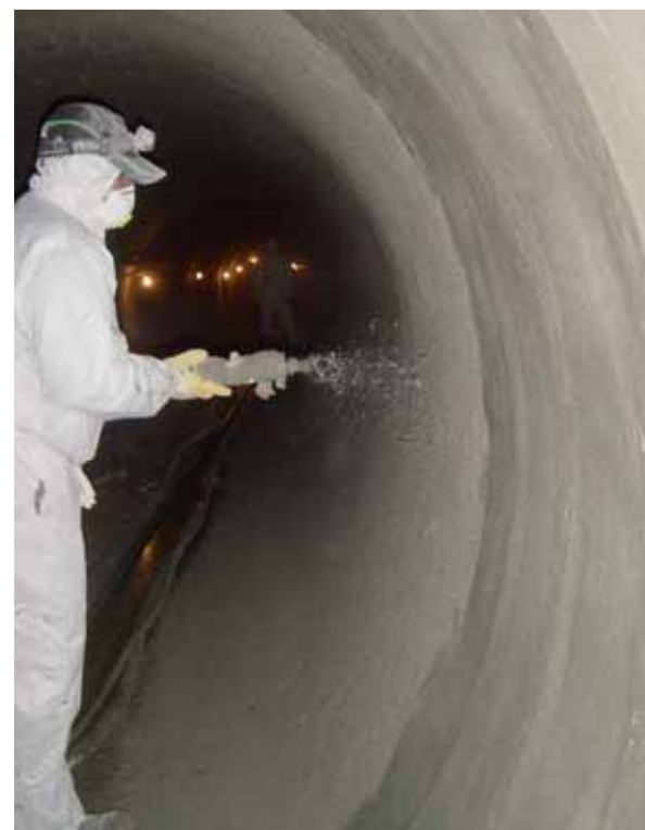
Travaux d'entretien de l'aqueduc de la Vanne (2013) : projection de mortier sur les surfaces intérieures de la conduite.
