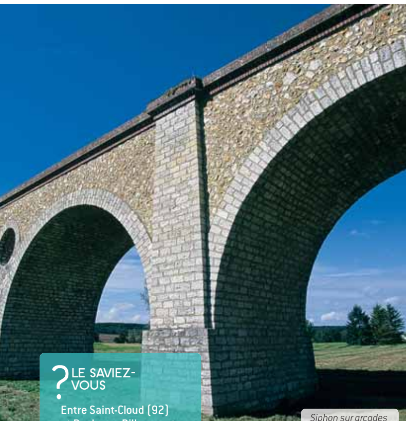
Siphon sur arcades de l'aqueduc de l'Avre à Montreuil (28).
