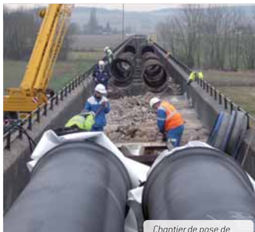
Chantier de pose de nouvelles conduites sur l'aqueduc de la Vanne [??].
