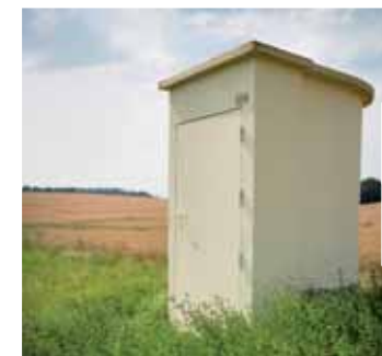
Regard permettant d'accéder à la galerie de l'aqueduc du Loing.
